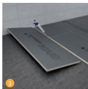
3 swissporBOARD Bauplatten ab 20 mm auf dem Untergrund verkleben und Stoßkanten mit swissporBOARD SB 911 Hybrid Kleb- und Dichtstoff versehen.
