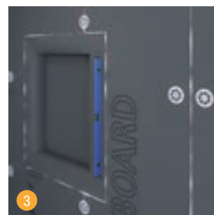
3 Alle swissporBOARD Bauplatten gleich- mäßig zueinander ausrichten.
