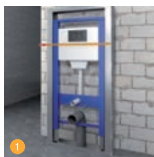
1 Vorwandelement und Ständerwerk aufbauen und ausmessen.
