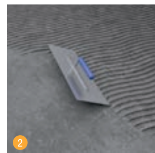
2 Je nach Untergrund vor dem Auftrag des swissporBOARD Flexkleber S1 schnell die Fläche grundieren.
