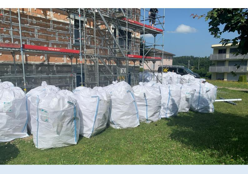
Dieses Merkblatt soll als Hilfestellung für die optimale Entfernung von EPS-Fassadendämmungen dienen und die Qualitätsanforderungen für die stoffliche Verwertung von EPS-Dämmplatten aufzeigen.
