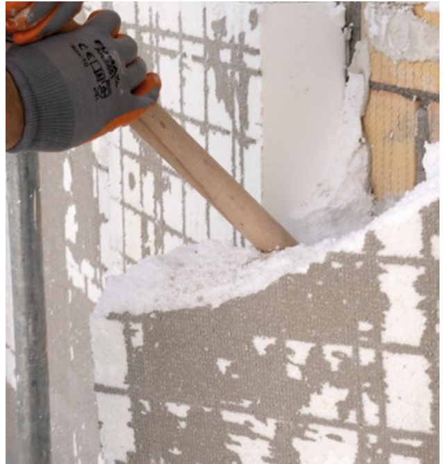
Der alte EPS-Dämmstoff wird manuell entfernt.
