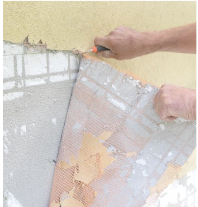
Die Einbettung wird abgetragen.
