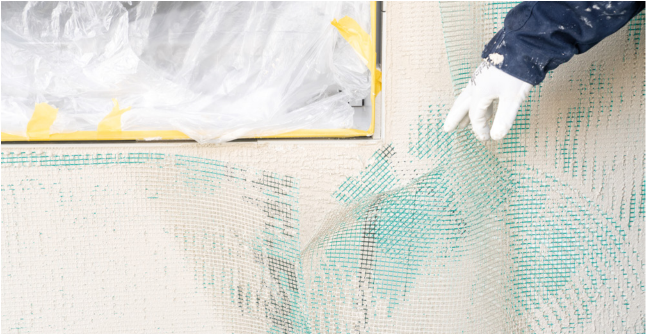
Neue Aussenwärmedämmung der Wohnüberbauung Sternmattquartier Luzern.
