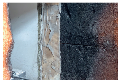
Oberflächlich beeinträchtigt Dämmstoff im Sturz-bereich nach Grossbrandversuch.
