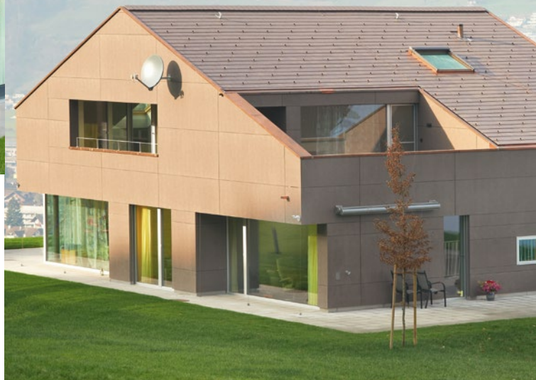
Objekt: Einfamilienhaus, 6374 Buochs
