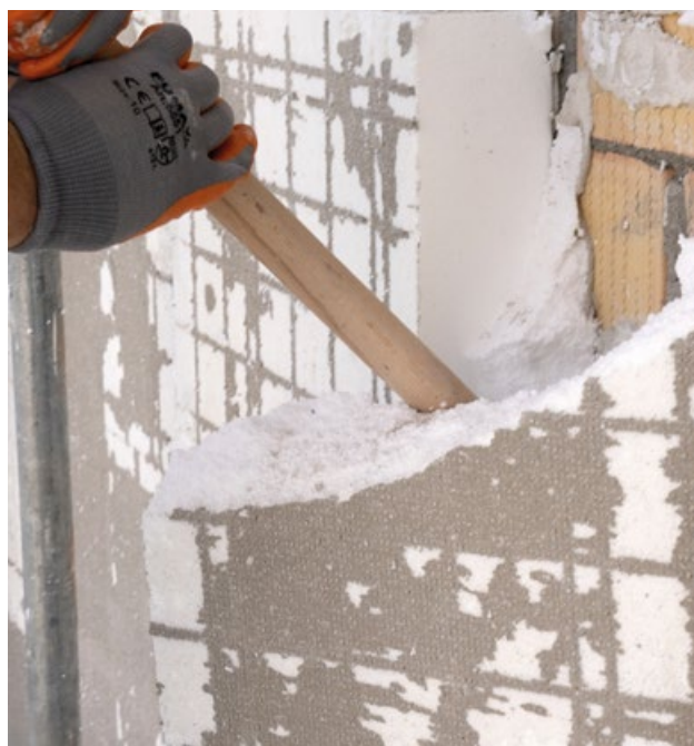
L'ancien matériau isolant en EPS est éliminé manuellement.
