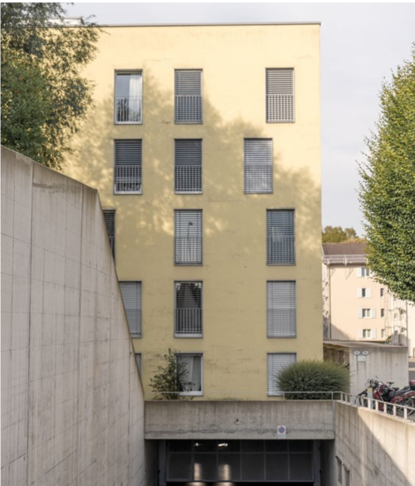
Façade avant la rénovation énergétique.
