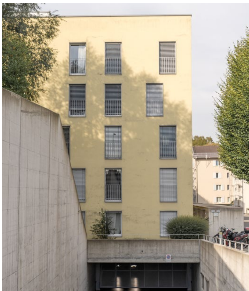
Fassade vor der energetischen Erneuerung.
